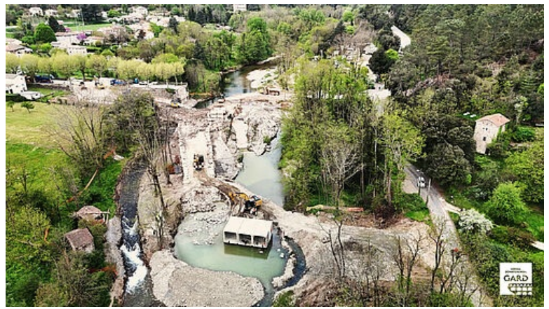
Vue aérienne du Pont provisoire de Chamborigaud © Jean de Saxce
